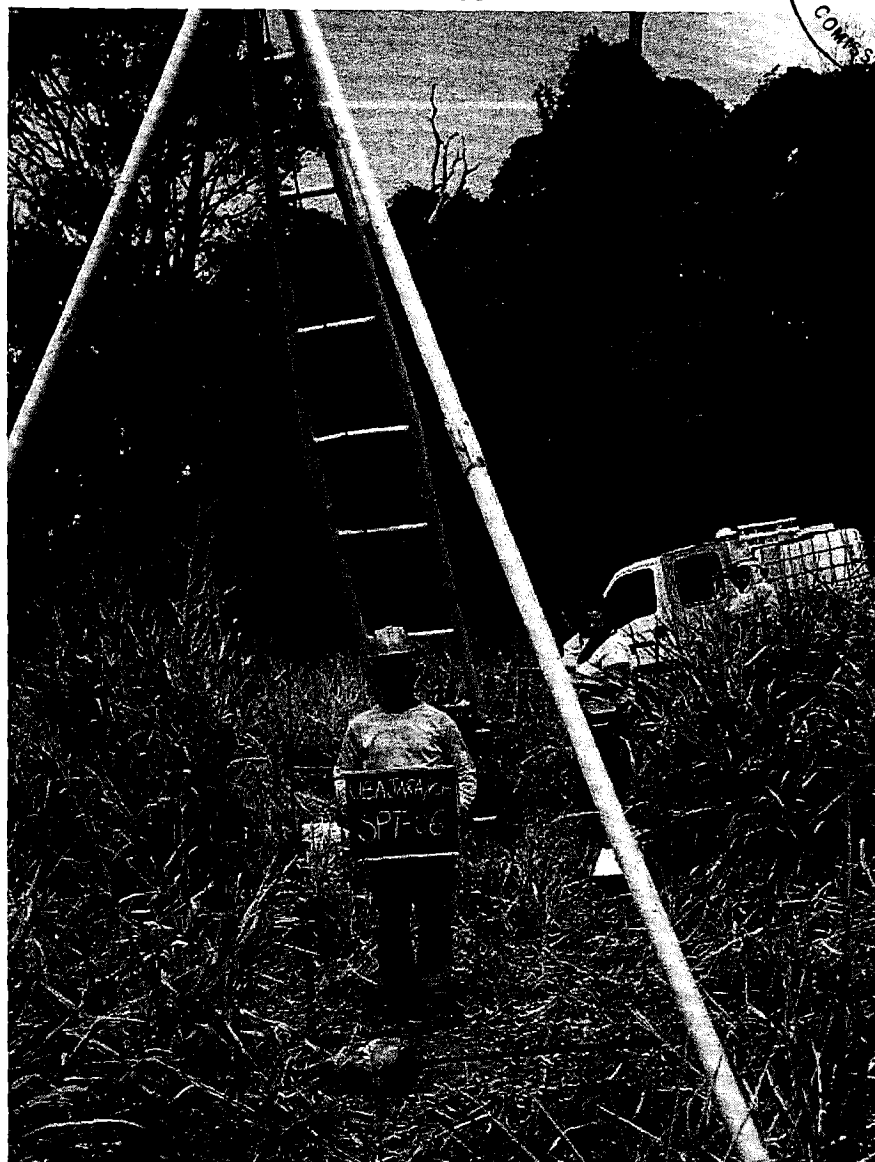
Instalação do furo SP-06
