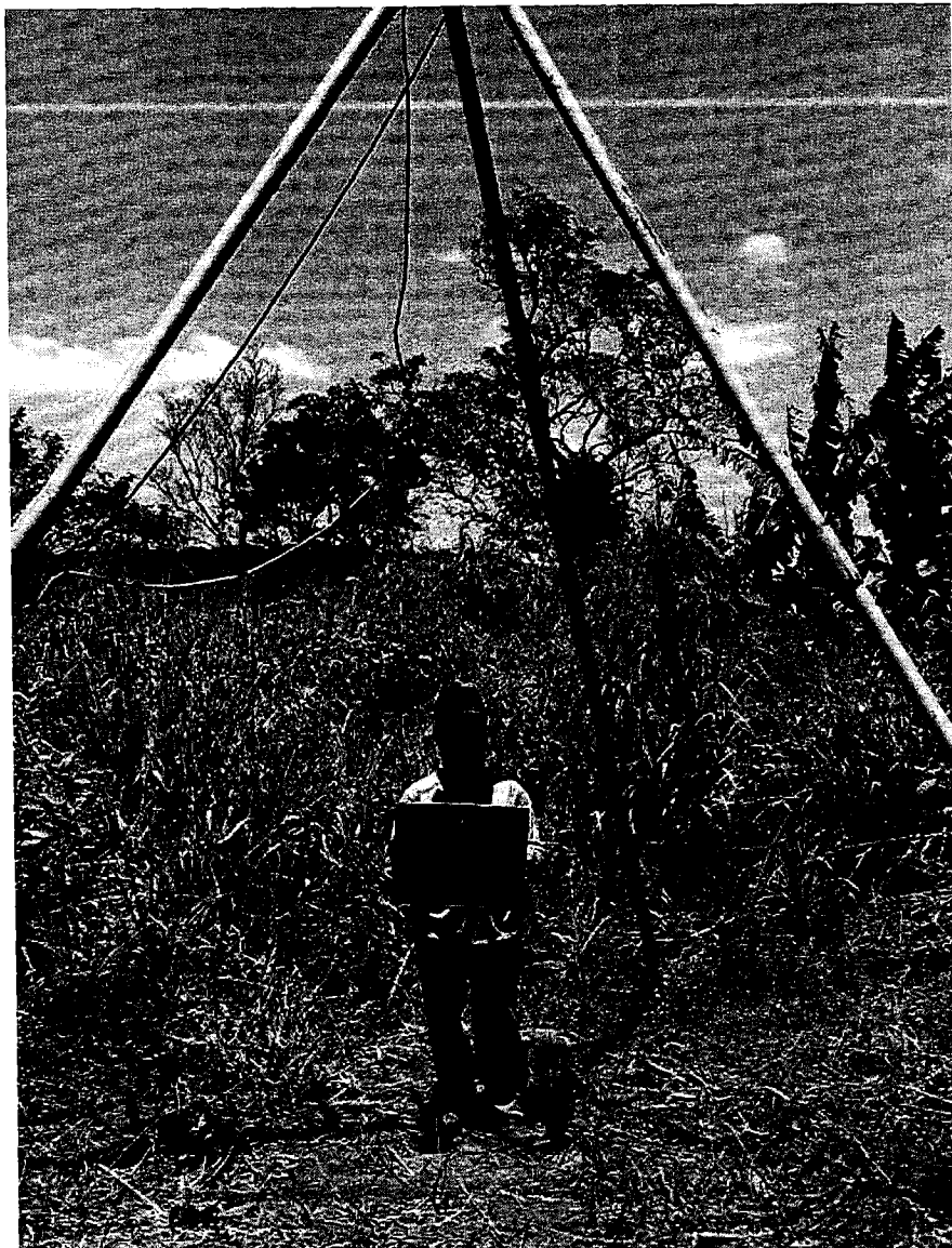
Instalação do furo SP-07
